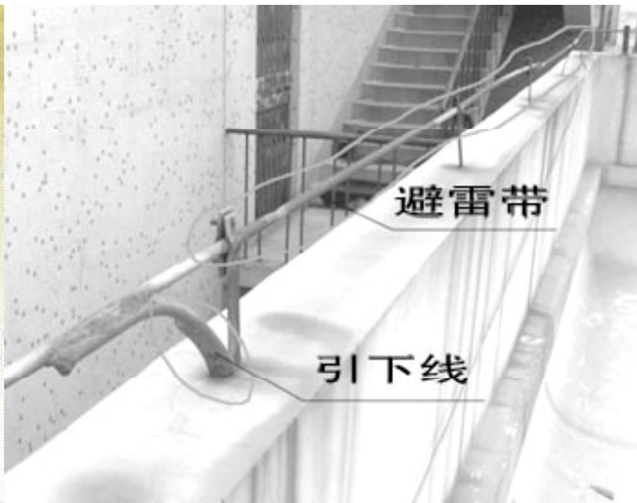
图6-9 建筑物避雷带示意
